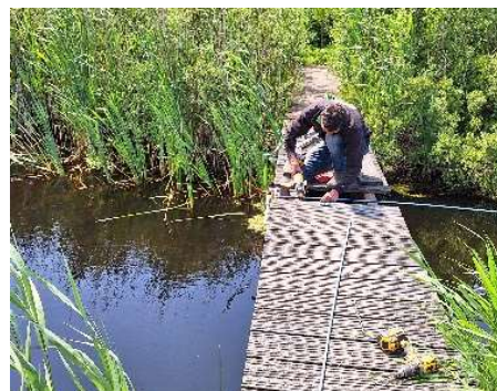
Het brugdeel wordt gerepareerd
